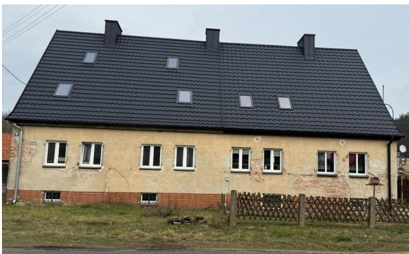
Nowe Dwory 99, budynek po remoncie pokrycia dachowego.
